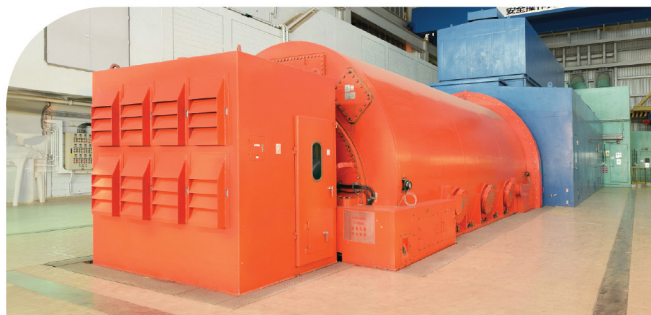
440MVA Turbine Generator 440MVA 渦輪發電機
